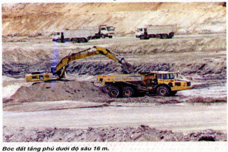
Bóc đất tầng phủ dưới độ sâu 16 m.
